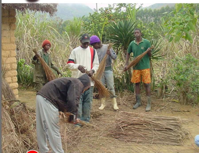
8 Aplicação do sapê no telhado, 2005
